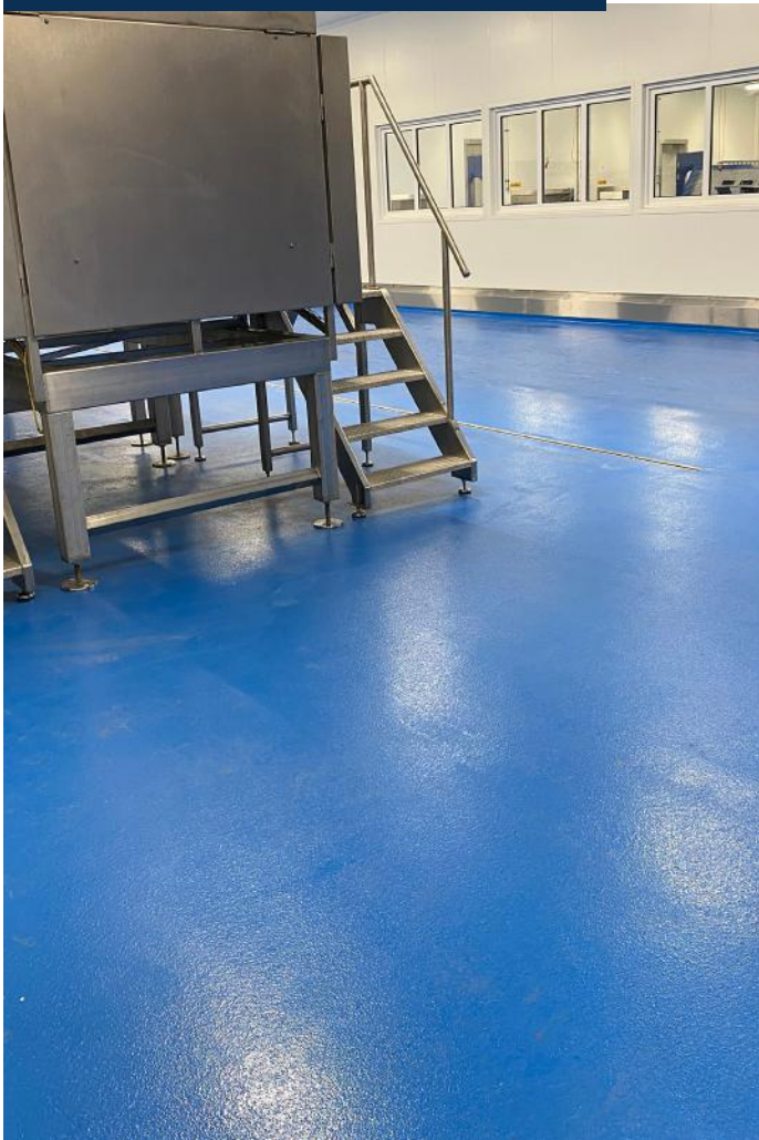
3010 m 2 Stonclad UR is geïnstalleerd
