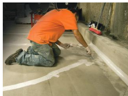
Stonhard-applicateur, die een scheur behandelt voor het aanbrengen van het Stondeck product
